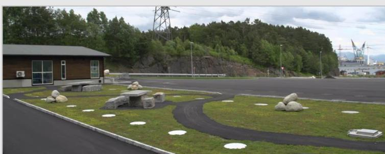
97 m<sup>2</sup> servicebygg, 185 m med horisontale PE-tankar under bakken, Ø=3m, fordelt med 2 slamavskiljarar (à 35 m), 2 slamlager (à 35 m) og ein ventiltank (45 meter lang).
