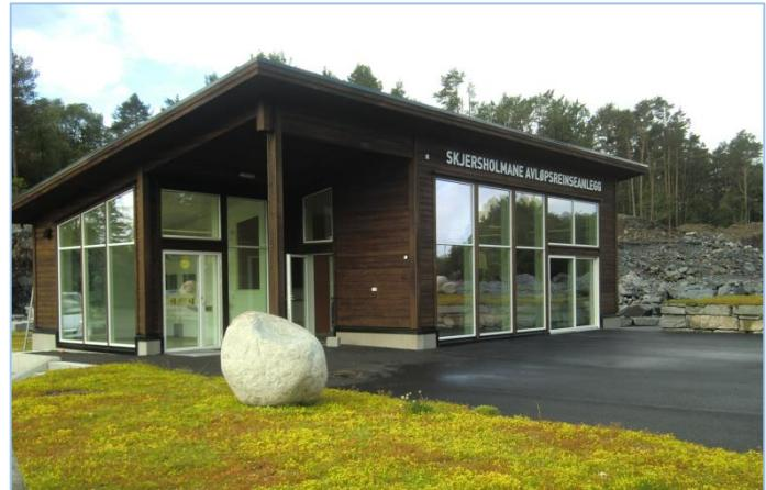
Skjersholmane avløpsreinseanlegg, - slamavskiljaranlegg for 6700 PE og som held kravet til både primærreinsing og akkreditert prøvetaking. Anlegget, **også omtala som verdas største slamavskiljaranlegg**, har eige kammer for sedimentering («slamavskiljar») og eige kammer for slamlager. Her er det rent, enkelt, moderne, - og minimalt med tilsyn. Tyngdekrafta gjer jobben!
